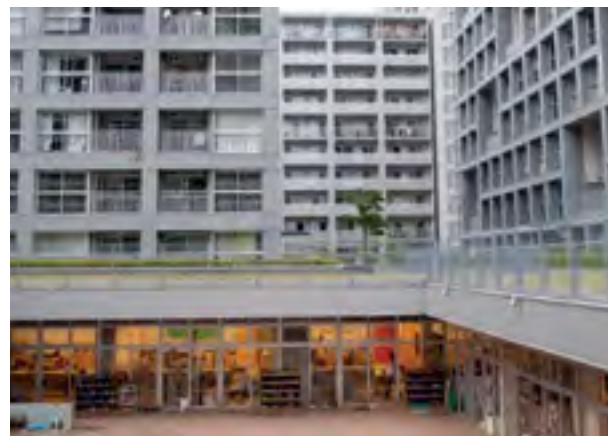
Este jardín de niños a nivel de calle en Shinanome, Tokio, Japón, es accesible y conveniente para niños y padres viviendo en la parte superior del edificio o en su entorno.
