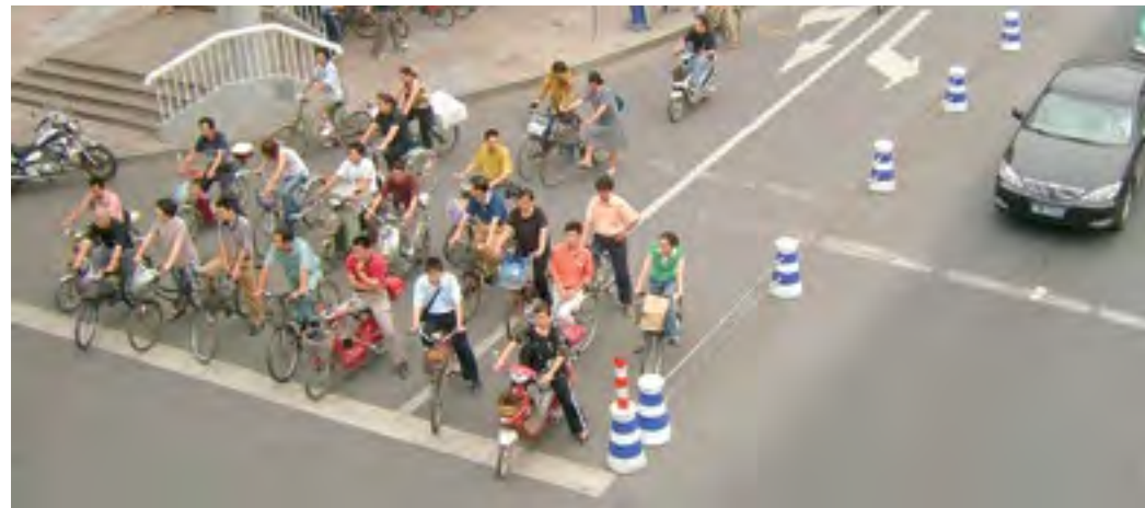
En Hangzhou, China, una ciclovia de alta capacidad incluye elementos físicos de confinamiento, zona delimitada para vuelta a la derecha y líneas adelantadas a vehículos motorizados para el alto ciclista.
